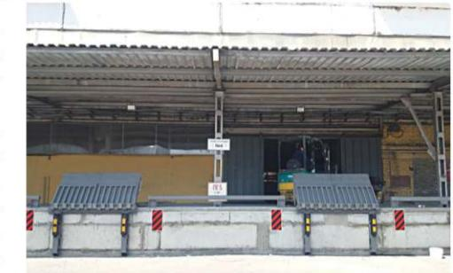
лами монтажного участка проводится капитальный ремонт кровли. На шротовом элеваторе реконструирован автомобилеразгрузчик ABC-50. Собственными силами проведено техническое обслуживание механических узлов и полностью заменены металлические конструкции платформы. ABC-50 эксплуатировался около 23 лет. После реконструкции объект функционирует в бесперебойном режиме.
