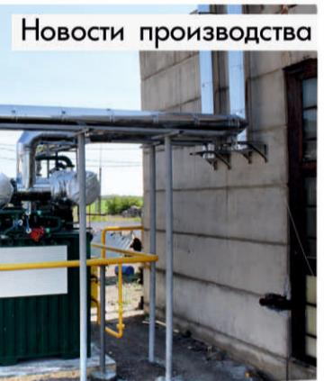
была построена дополнительная воздушная линия для передачи собственной энергии на центральную распределительную подстанцию бройлерного производства птицефабрики. Был подведен газ и смонтирована теплотрасса. В конце июня - пуско-наладочные работы, в первой декаде июля - пуск установок.
